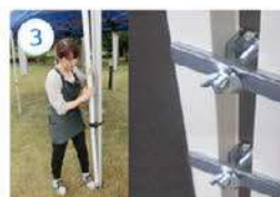
専用支柱を立て、tent支柱に連結具で 上下2カ所を固定連結します。
