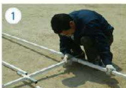
骨組みを組み立てます。
